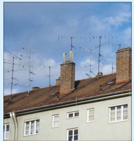
Bild 3: Material für einfache Dipolantennen steht vielerorts in Form nicht mehr genutzter Band-III-Fernsehantennen zur Verfügung.
