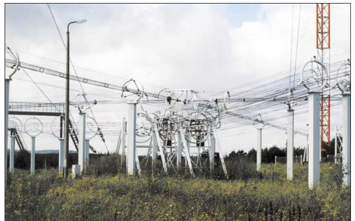
Konstruktion zum Umschalten der Antennenstrahler zwischen aktivem und passivem Betrieb
